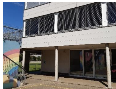
Ettingen Schulhaus Hintere Matte Gempenweg 25 4107 Ettingen
